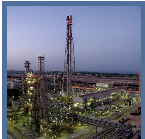
Die SAFCO4 Anlage von Uhde ist eine der größten Ammoniakanlagen der Welt/ The SAFCO4 plant of Uhde is one of the world's biggest ammonia plants
